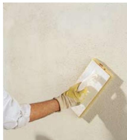
Der Faser-Leichtputz MFL von quick-mix ist der ideale Putz für modernes Bauen mit extrem leichten Wandbaustoffen. Der rein mineralische Faser-Leichtputz ist hochergiebig, faserverstärkt und funktioniert ohne Grundierung auf stark saugenden Untergründen sowie auf extrem leichten Wandbaustoffen. Gemäß den „Leitlinien für das Verputzen von Mauerwerk und Beton“ des IWM wird er als Leichtputz Typ II klassifiziert.
